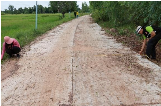
โครงการ ถนนบ้านดอนกอก หมู่ที่ 2 ตำบลหนองพลวง เข้ม บ้านถนนโพธิ์ หมู่ที่ 5 ตำบลประทาย อำเภอประทาย จังหวัดนครราชสีมา (ก่อสร้างถนนคอนกรีตเสริมเหล็ก กว้าง 4 เมตร ยาว 220 เมตร หนา 0.15 เมตร ตามแบบและรายละเอียดที่ อบจ.นม.กำหนด)
