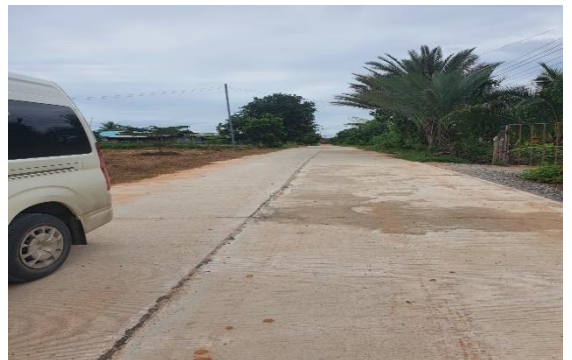
โครงการถนนบ้านทับม้า หมู่ที่ 10 ตำบลสีคิ้ว - บ้านมอดินแดง หมู่ที่ 6 ตำบลหนองหญ้าขาว อำเภอสีคิ้ว จังหวัดนครราชสีมา (ก่อสร้างถนนคอนกรีตเสริมเหล็ก กว้าง 5.00 เมตร ยาว 168 เมตร หิน 0.15 เมตร ไหล่ทางหินคลุกกว้างเฉลี่ยข้างละ 0.50 เมตร หรือพื้นที่ คสล.ไม่น้อยกว่า 840 ตารางเมตร)
