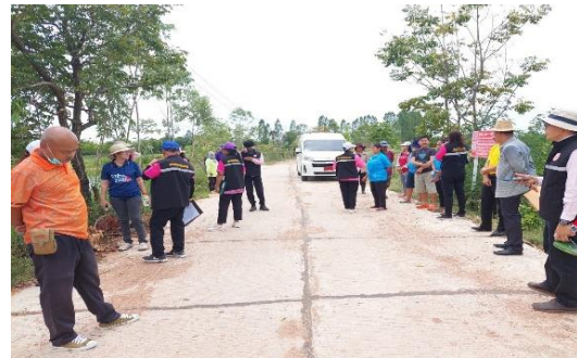
โครงการถนนสายบ้านคอนน้อย หมู่ที่ 3 - บ้านโนนข้าวตาก ตำบลเมืองนาท อำเภอลำดวน จังหวัดนครราชสีมา (ก่อสร้างถนนคอนกรีตเสริมเหล็ก กว้าง 4 เมตร ยาว 217 เมตร หนา 0.15 เมตร ไหล่ทางลูกรัง กว้างเฉลี่ยข้างละ 0.20 เมตร หรือตามสภาพพื้นที่ หรือมีพื้นที่ คสล.ไม่น้อยกว่า 868 ตารางเมตร ตามแบบและรายละเอียดที่ อบจ.นม.กำหนด)
