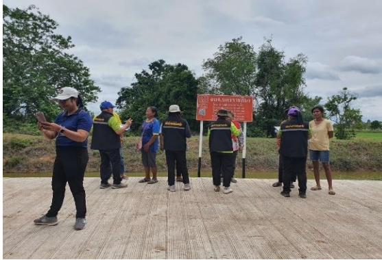
โครงการ ถนนบ้านดอนกอก หมู่ที่ 2 ตำบลหนองพลวง เข้ม บ้านถนนโพธิ์ หมู่ที่ 5 ตำบลประทาย อำเภอประทาย จังหวัดนครราชสีมา (ก่อสร้างถนนคอนกรีตเสริมเหล็ก กว้าง 4 เมตร ยาว 220 เมตร หนา 0.15 เมตร ตามแบบและรายละเอียดที่ อบจ.นม.กำหนด)
